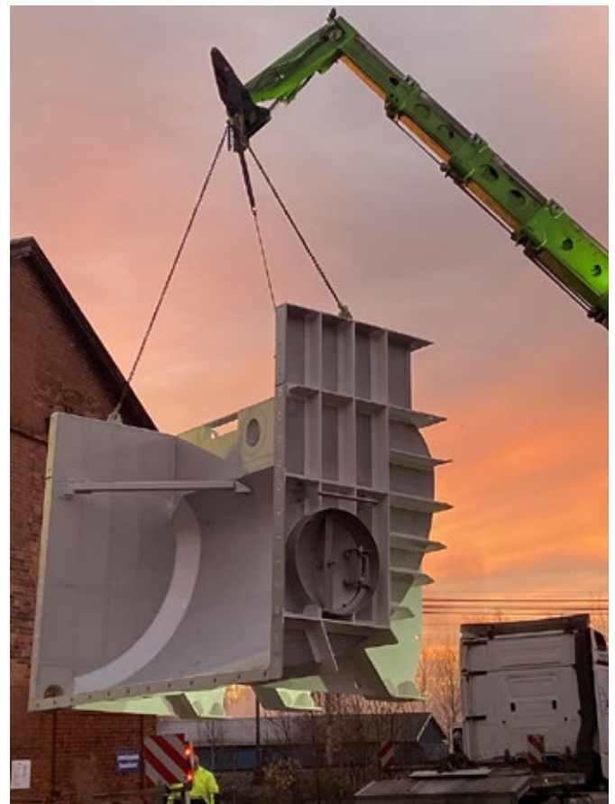
Leverans till Säffle av en upplösare till den nya hanteringen av extern massa.
