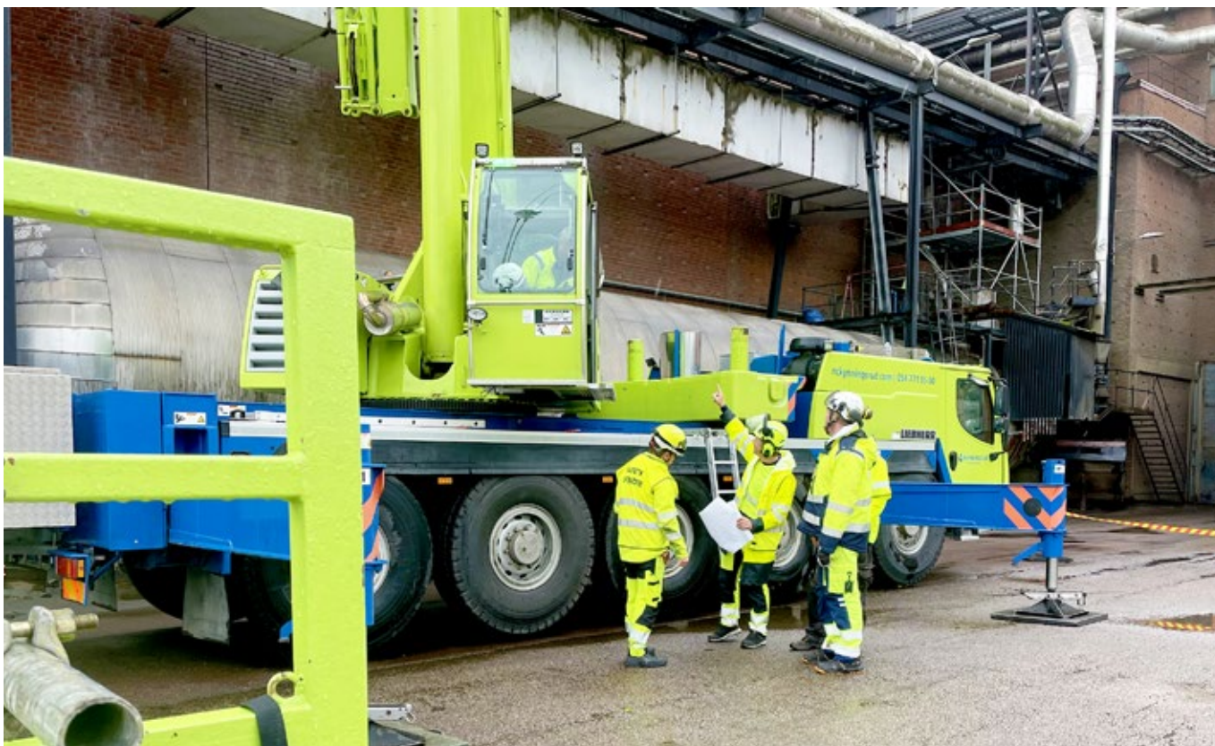
Planering av lyft under underhållsstoppet i Bäckhammar hösten 2021.
