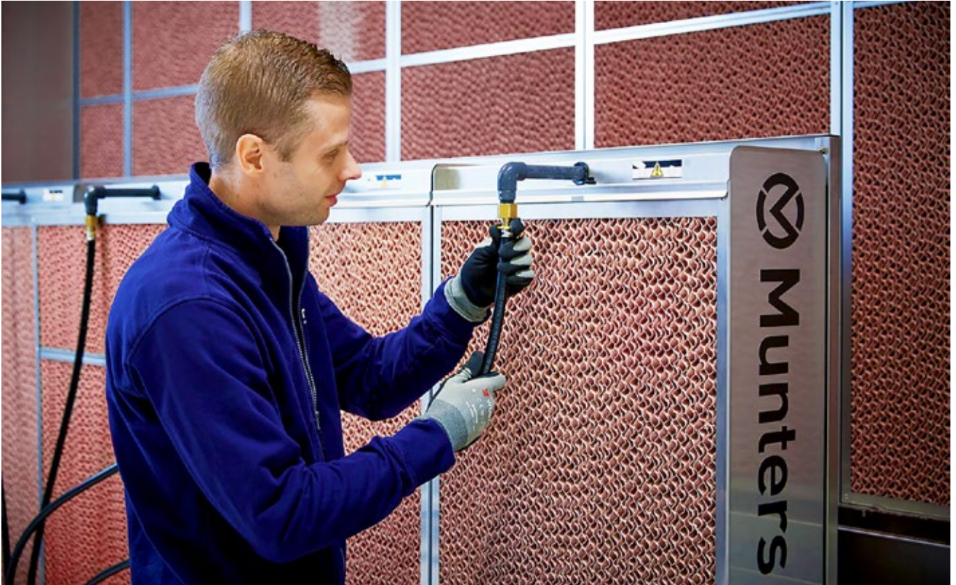
Montering av klimatanläggning innehållande absorbentpapper från Nordic Paper.
